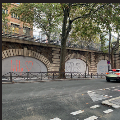
DROIT DANS LE MUR
