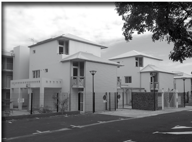
La Maison-Relais de Saint-Pierre (CIAS)
