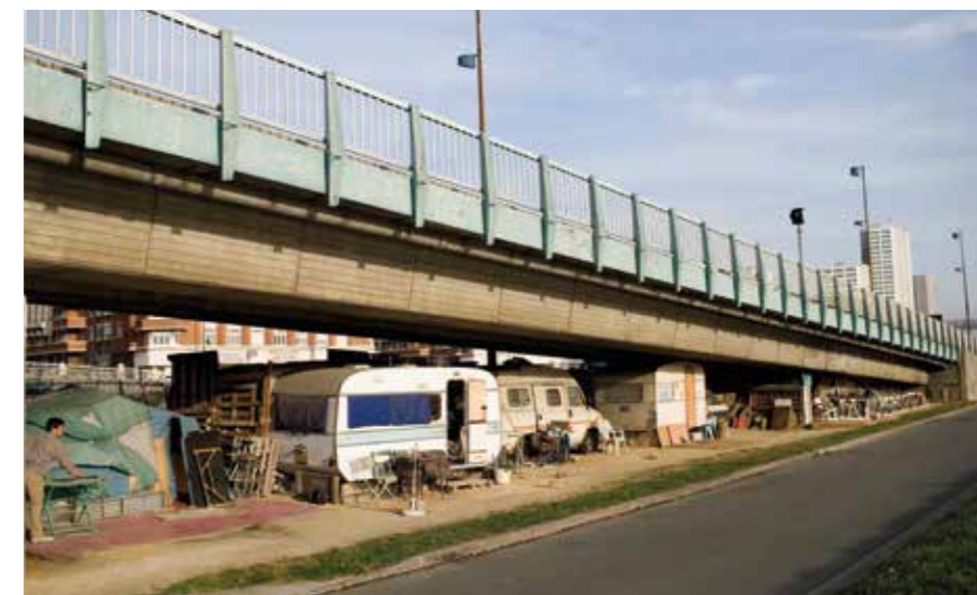
Installation sous le périphérique.
